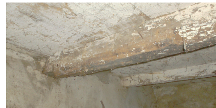
ABACO sistemi costruttivi (Tavola A1) e foto-rilievo di trave ammalorata
